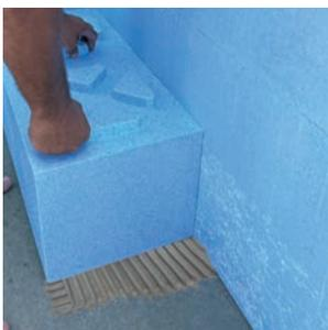
**6** Pose et ajustement du bloc
